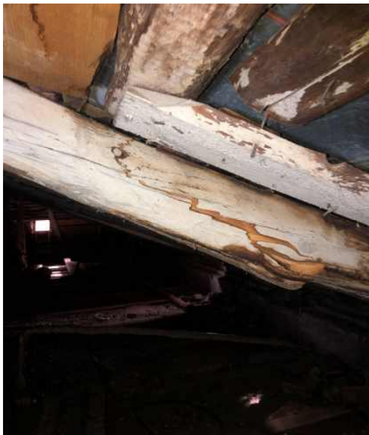
Фото №48 Втрата міцності у вигляді їх розриву та деформація поперечного перерізу кровів
