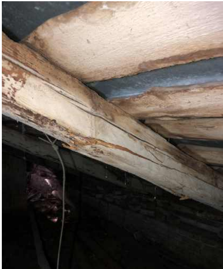
Фото №47 Втрата міцності у вигляді їх розриву та деформація поперечного перерізу кровів
