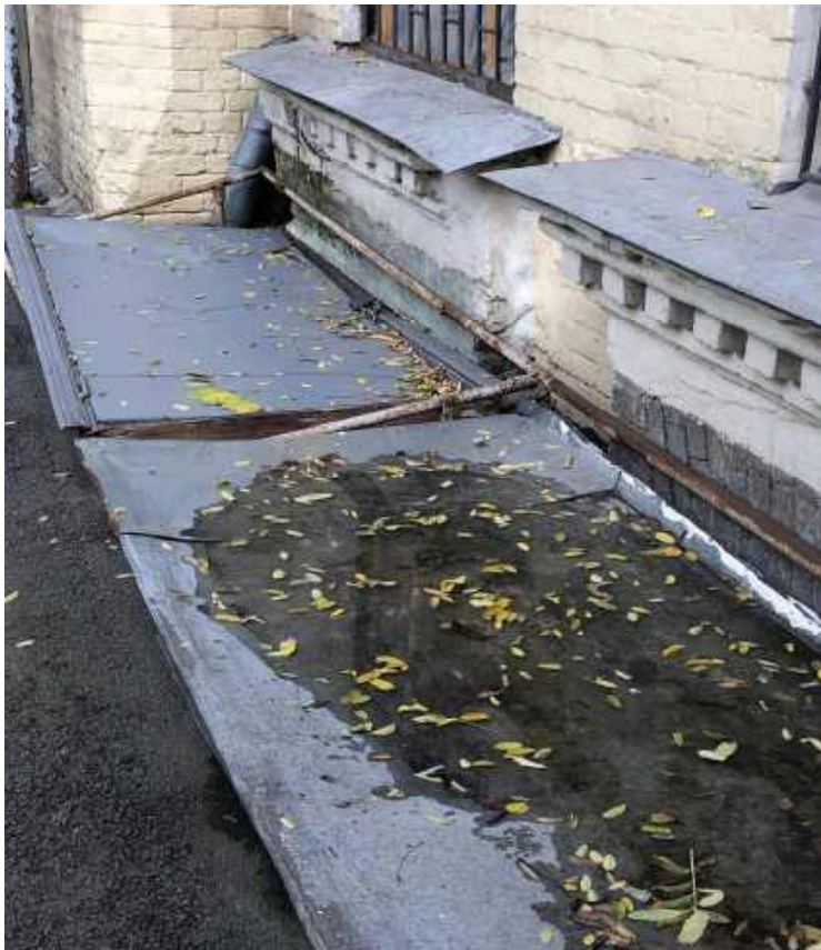
Фото №14 Незадовільний стан захисних козирків прямиків та системи водовіведення
