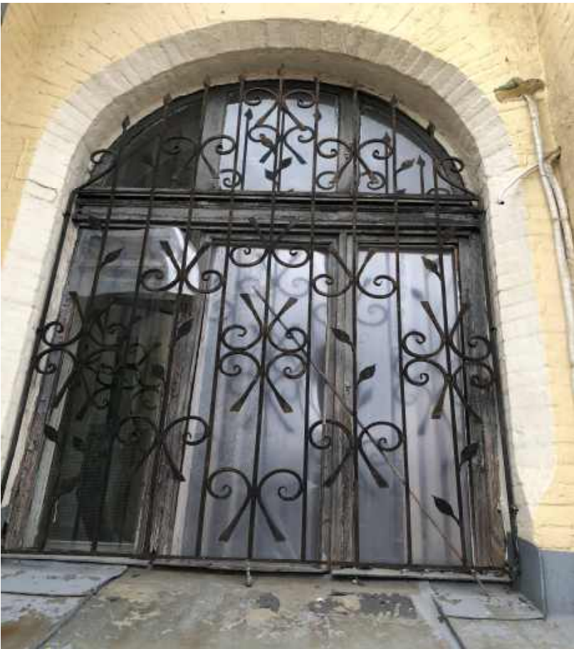
Фото №3 Втрачене заскління вікон, деструкція та втрати дерев'яних рам
