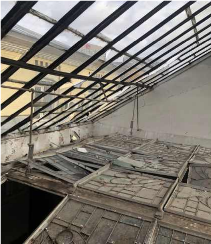
Фото №66 Загальний технічний стан несучих та огорожуючих конструкцій світлового ліхтаря
