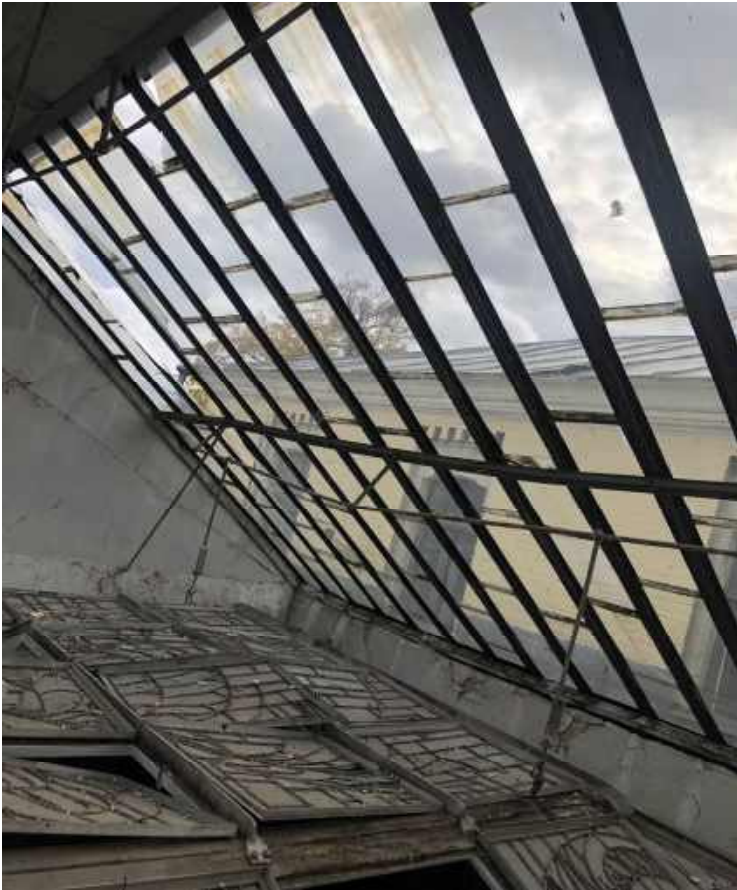
Фото №65 Загальний технічний стан несучих та огорожуючих конструкцій світлового ліхтаря
