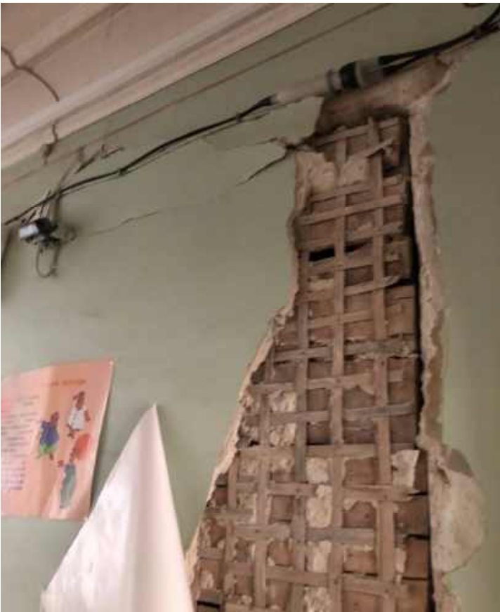
Фото №41 Втрати дерев'яної перегородки, внаслідок вибухової хвилі ( 2 поверх)
