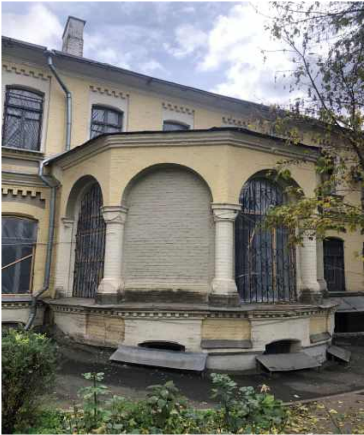
Рис. 2 – Фрагмент дворового фасад. Загальний вид.
