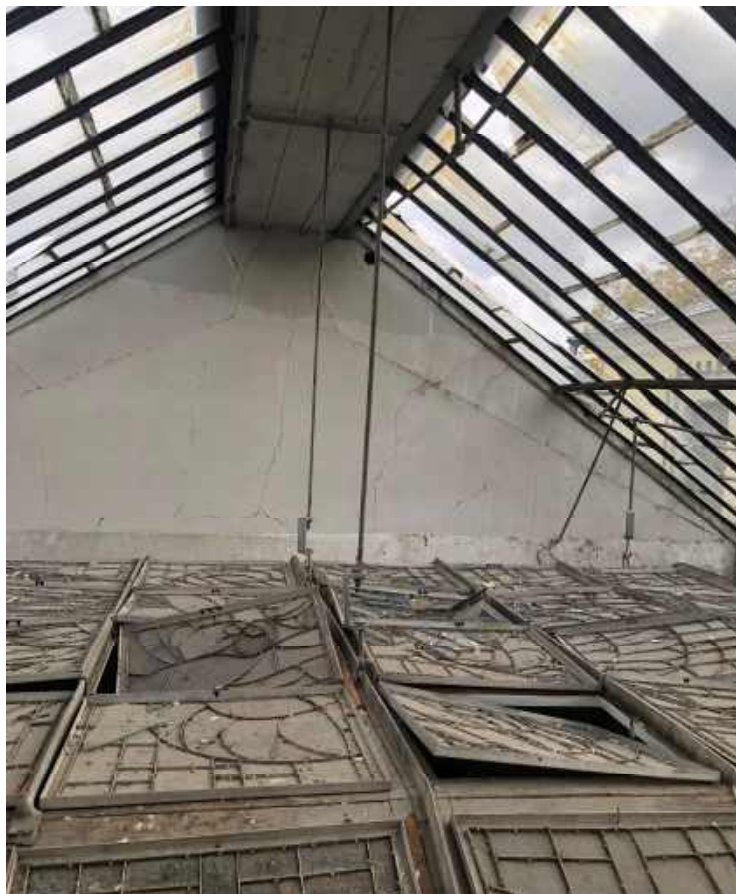
Фото №63 Загальний технічний стан несучих та огорожуючих конструкцій світлового ліхтаря
