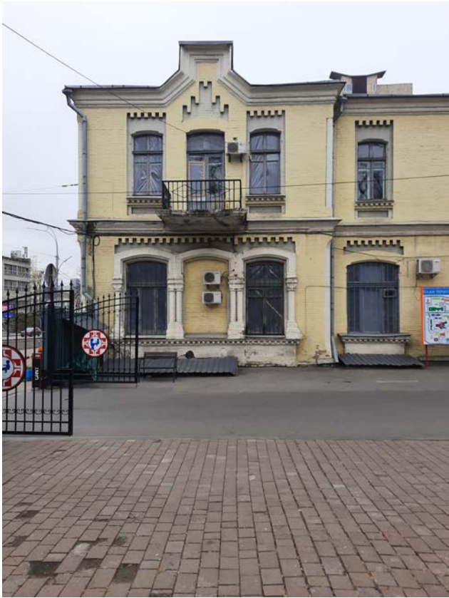
4. Північний фасад. Всі вікна пошкоджені. Плита балкону у незадовільному стані.
