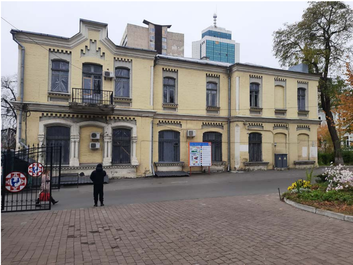
4. Північний фасад. Всі вікна пошкоджені. Плита балкону у незадовільному стані.
