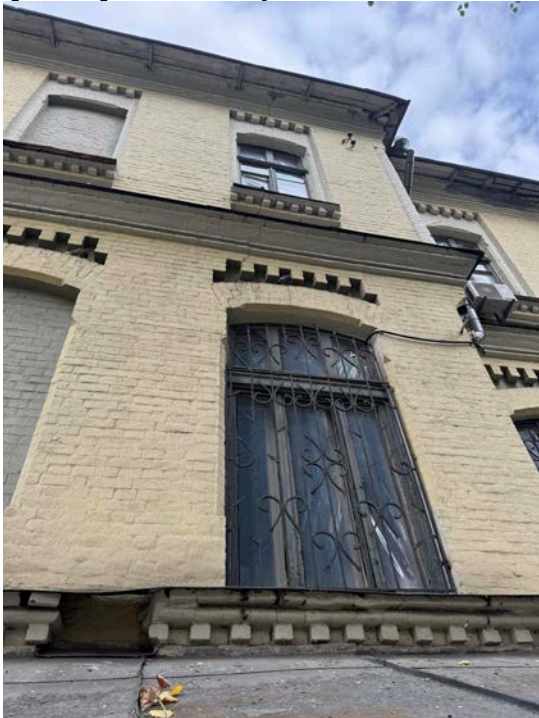
9. Південний фасад, ліва частина. Найбільш постраждала частина будівлі. Тут знаходяться сходи (Сходи 2), нерівномірно розперті стіни сприяли деформаціям, але невелика кількість прорізів стала стримуючим фактором. Цей кут є найближчий до епіцентру.
