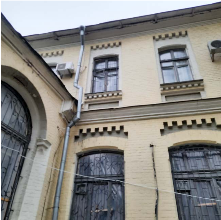
7. Західний фасад. Пошкоджений карниз. Крокви "піднялися" з нормального положення,разом з кобилками.
