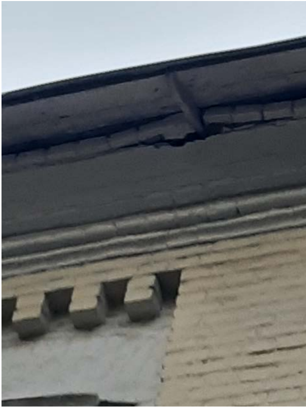
7. Західний фасад. Пошкоджений карниз. Крокви "піднялися" з нормального положення,разом з кобилками.
