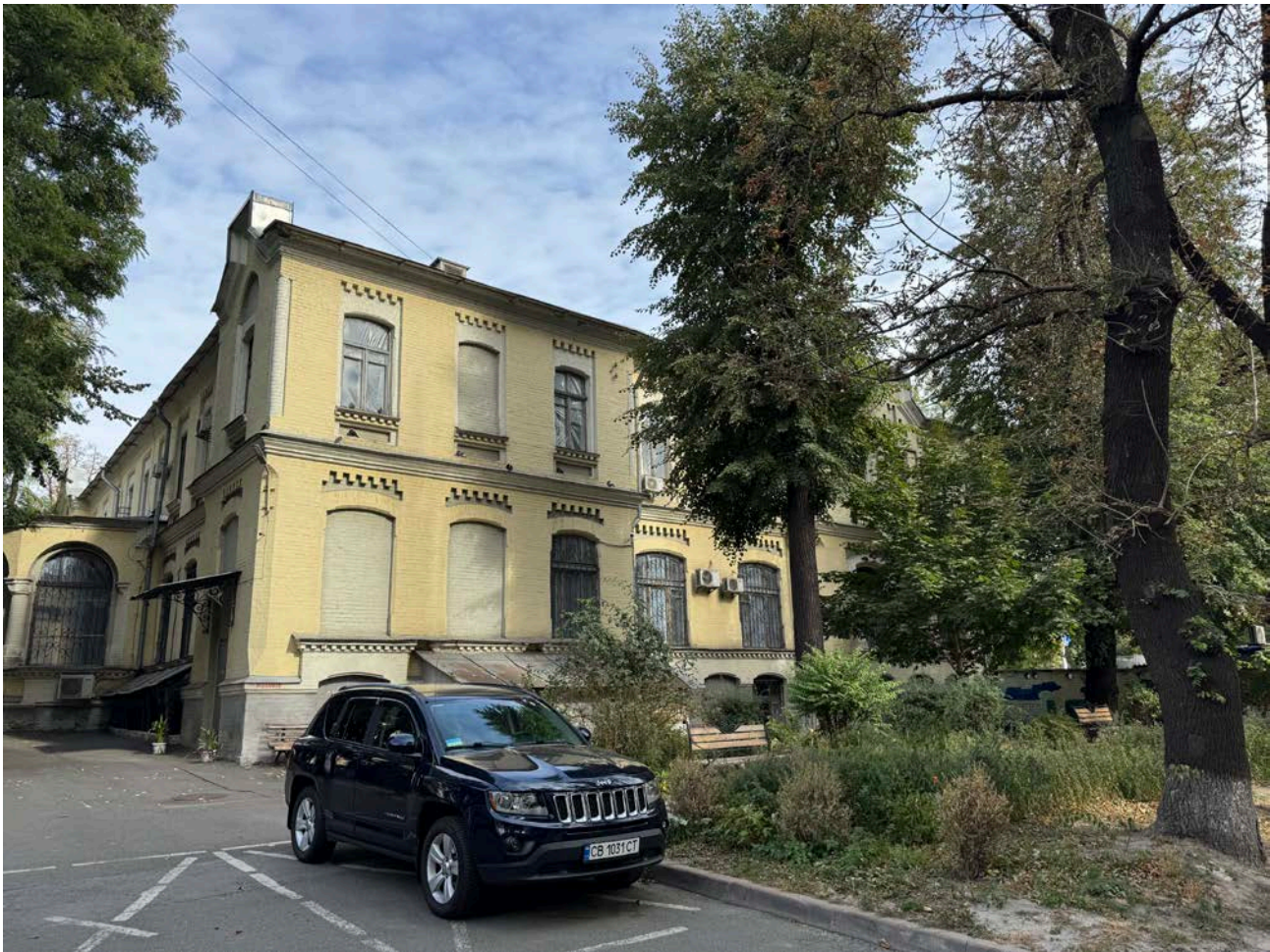
9. Південний фасад, ліва частина. Найбільш постраждала частина будівлі. Тут знаходяться сходи (Сходи 2), нерівномірно розперті стіни сприяли деформаціям, але невелика кількість прорізів стала стримуючим фактором. Цей кут є найближчий до епіцентру.
