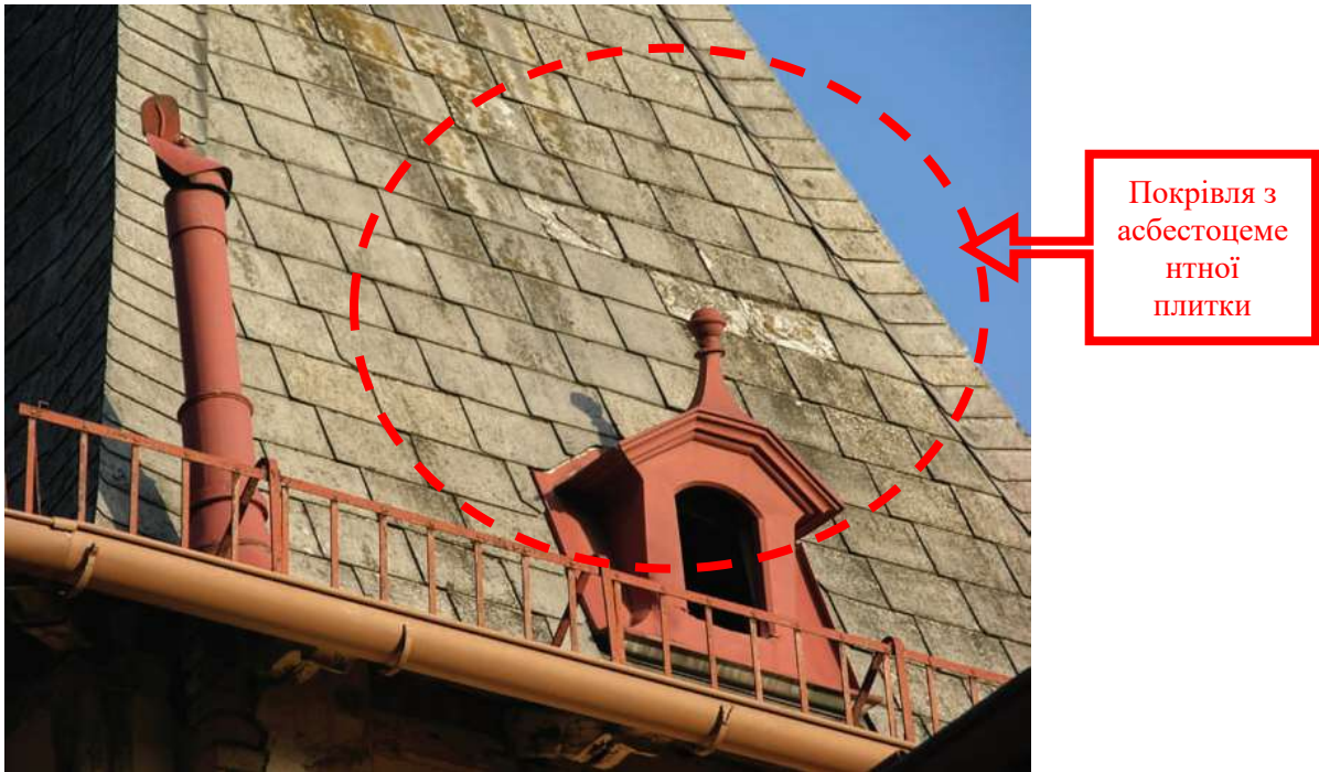
Дах покритий асбестоцементною плиткою
