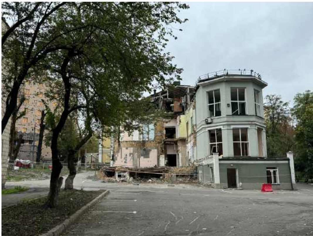
Загальний вигляд частково зруйнованої будівлі
