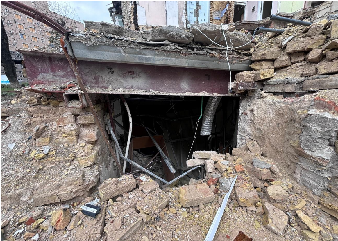
Фото 6. Металеві балки з/б перекриття. Пд.-зх. крило
