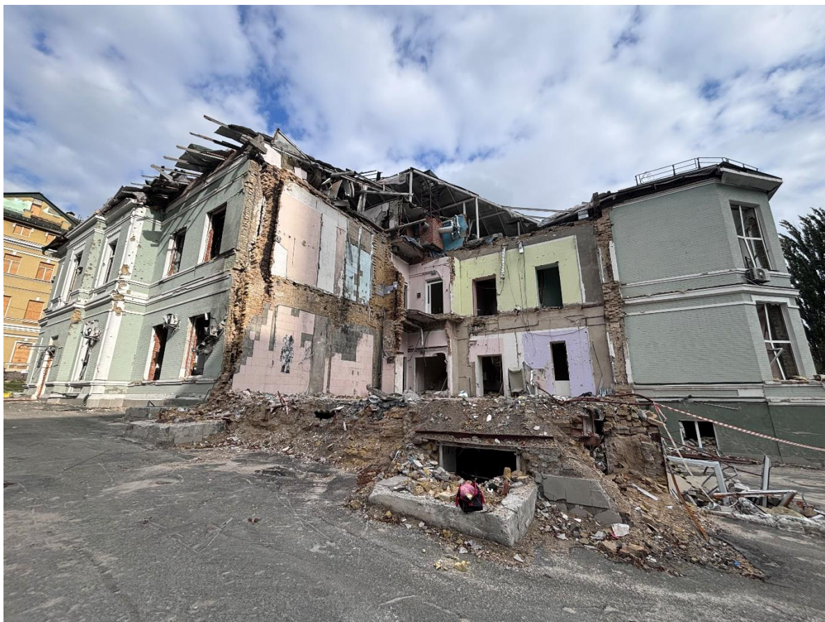
Фото 19. Ухил асфальтового вимощення вздовж пд.-зх. крила. Полотно вимощення пронизане тріщинами
