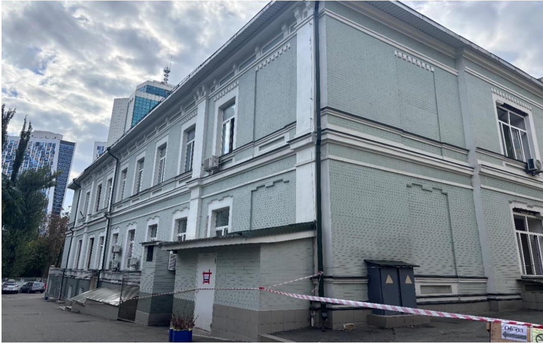
Фото 8. Загальний вигляд кута фасадів. Вигляд зі сходу
