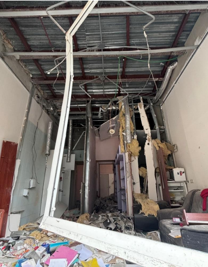
Фото 23. Приміщення інтер'єру пн-зх. крила
