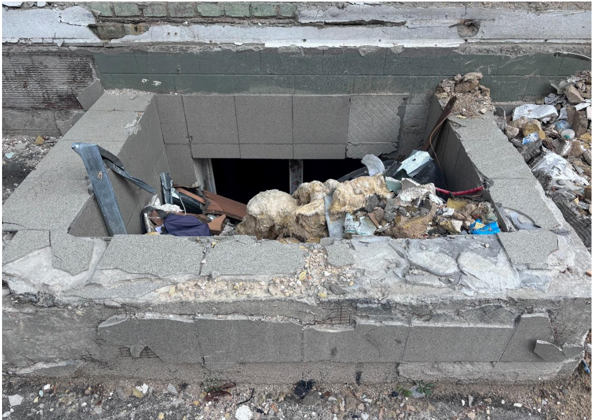
Фото 17. Втрата облицкування стінок відкритого приямку
